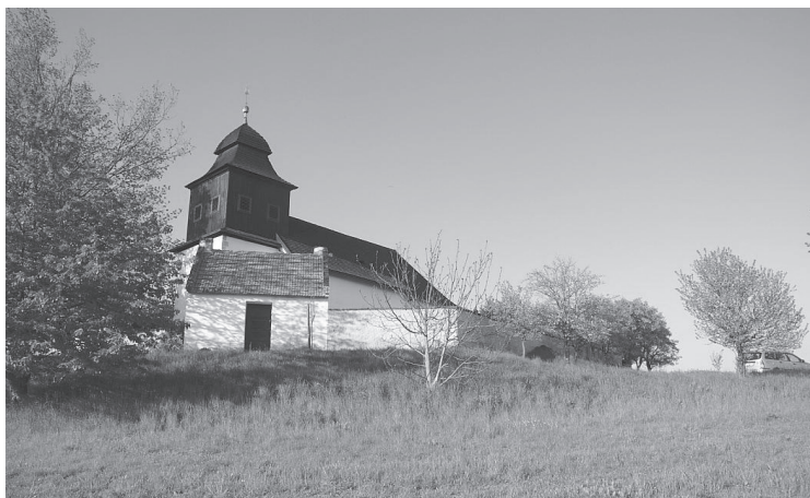
Kostel sv. Klimenta v Jasenici
